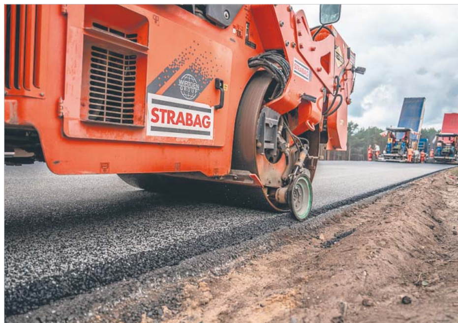
Nawierzchnia obwodnicy jest odporna na warunki atmosferyczne i powstawanie kolein
